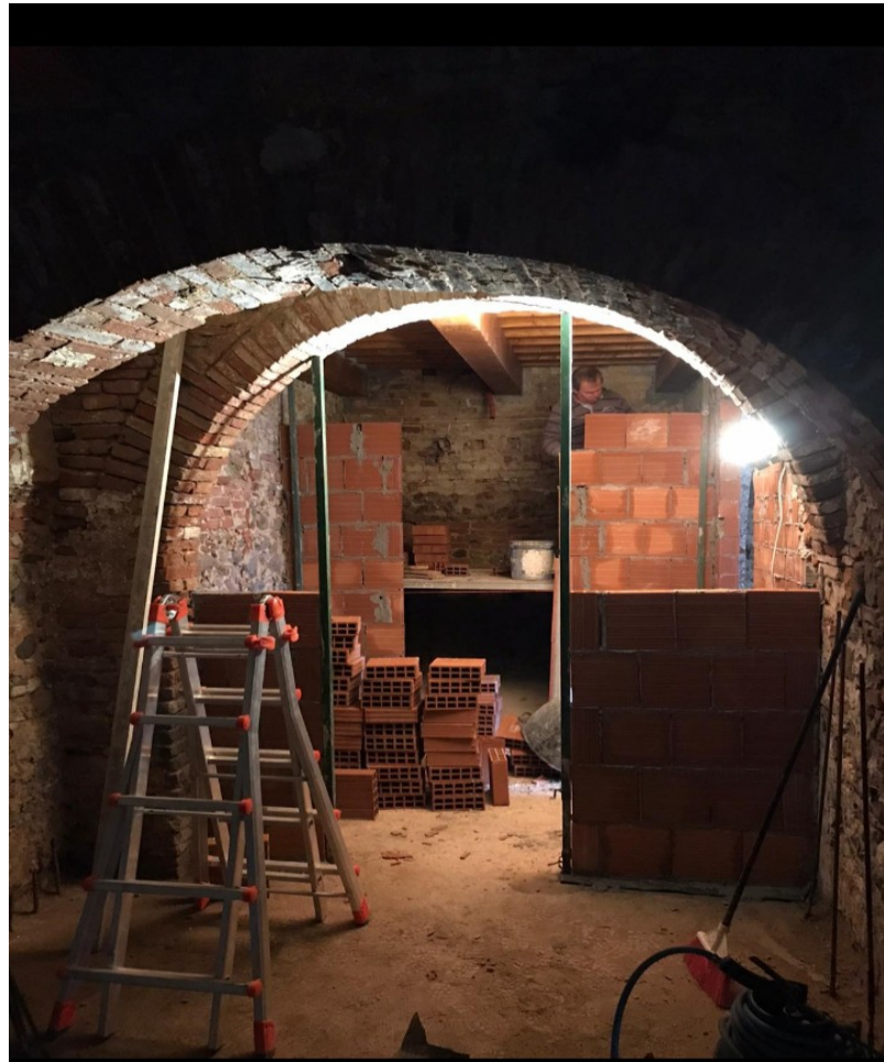
FOTO DURANTE I LAVORI, DICEMBRE 2019 – MARZO 2020
